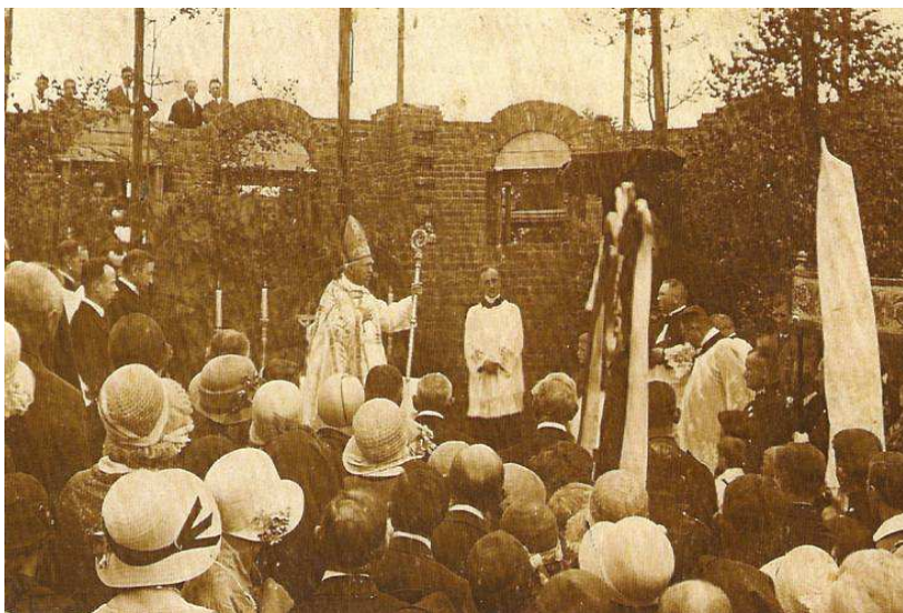
Położenie kamienia Węgielnego pod budowę nowego kościoła w Mroczy. Rok 1929/30 (Fot. ze zbiorów Pani Marczyk z domu Mróz)
